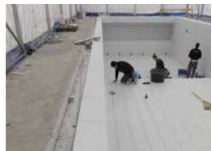
L'étanchéité est recouverte de dalles en céramique.
