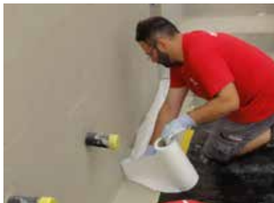
Travaux d'étanchéité avec Wecryl 235 et le voile Weplus.
