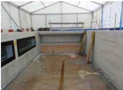
Le bassin avant les travaux d'étanchéité.
