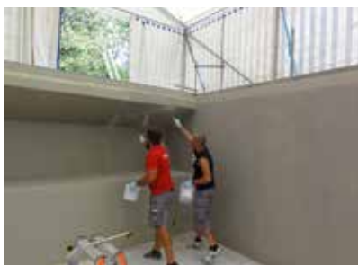
Le sable qui permettra la pose des dalles est répandu sur Wecryl 235.
