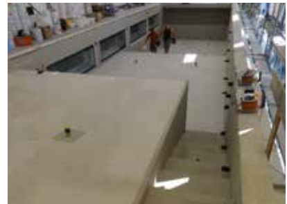
Le bassin est désormais étanche.
