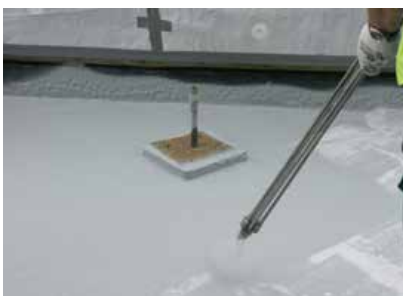
Les deux composants sont mélangés juste à la sortie de la buse de pulvérisation.
