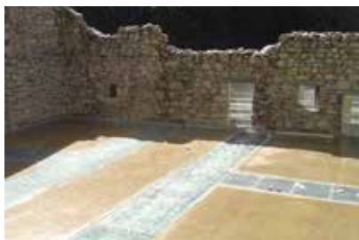
4. L'enduit d'imprégnation Wecryl 276 a été appliqué en couche fine.
