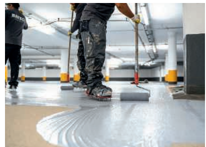
Auf die vom überschüssigen Quarzsand gesäuberte Oberfläche kam eine zweite Schicht Wecryl 408 als Kopfversiegelung.
