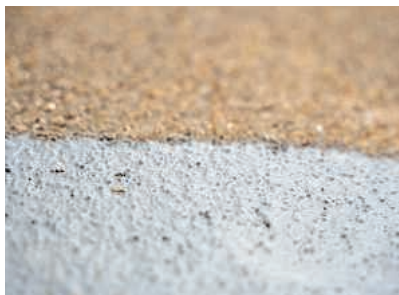
In die noch frische erste Lage Wecryl 408 wurde direkt der WestWood Quarzsand (0,4 – 0,8 mm) im Überschuss (Verbrauch ca. 7,0 kg/m 2 ) eingestreut.
