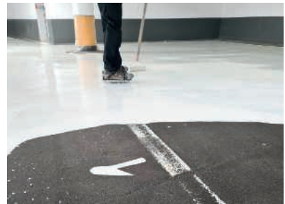
Durch den weißen Farbton der Grundierung Wecryl 110 ließ sich die erforderliche Schichtstärke optimal kontrollieren.
