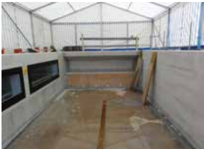
Le bassin avant les travaux d'étanchéité.
