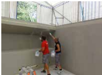
Le sable qui permettra la pose des dalles est répandu sur Wecryl 235.
