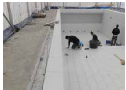
L'étanchéité est recouverte de dalles en céramique.
