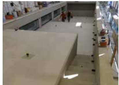
Le bassin est désormais étanche.
