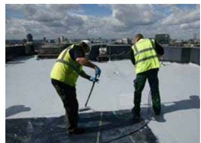
L'un des ouvriers pulvérise la première couche dans laquelle le voile est ensuite immédiatement posé avant que ne soit appliquée la seconde couche en une seule étape.
