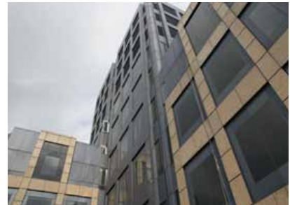
Les tuyaux du système de pulvérisation ont été placés le long de la façade afin d'alimenter plusieurs niveaux.
