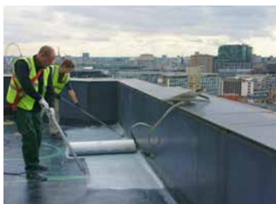
L'un des ouvriers pulvérise la première couche dans laquelle le voile est ensuite immédiatement posé avant que ne soit appliquée la seconde couche en une seule étape.
