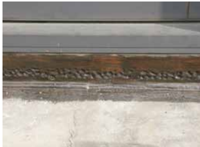
Un support varié: asphalte inégal et béton.
