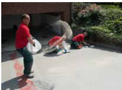
Application de la couche de protection en mortier autolissant et sablage.
