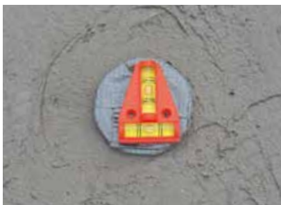
Le capteur doit être placé à l'horizontale dans le chauffage de la rampe.
