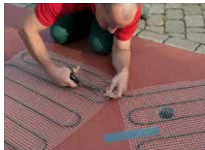
Mesure, découpe et fixation de la trame chauffante.
