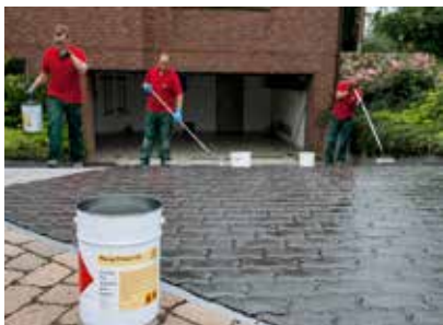
Application de l'enduit d'imprégnation sur les pavés nettoyés par grenailage et poncés.
