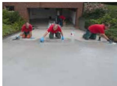
Mise en œuvre de la couche d'usure sous la forme d'un revêtement à relief résistant aux fortes sollicitations mécaniques.
