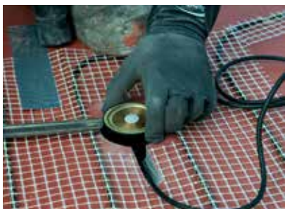
Montage du capteur d'humidité entre les serpentins du chauffage.
