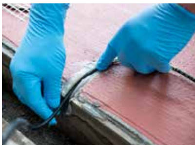
Pose des câbles d'alimentation dans la rigole.
