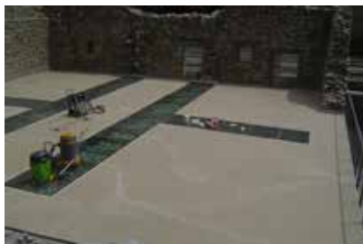
2. Le support à rénover a été nettoyé de manière adéquate, puis préparé pour le revêtement suivant.
