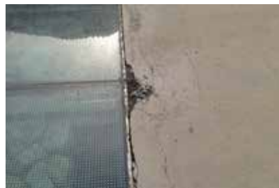
3. Les raccords le long des éclairages zénithaux étaient les premiers touchés. Ils ont été mis de niveau avec le mortier Wecryl 242 après avoir préparé le support.
