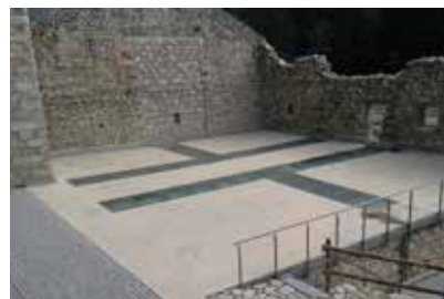
6. Le mortier autolissant Wecryl 233 égalise la surface, il ponctue les fissures capillaires et fait office d'étanchéité. La mise en couleur finale a été réalisée avec la finition Wecryl 288.
