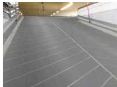
Le revêtement à relief Wecryl 410 résiste à l'abrasion et protège la structure des infiltrations de chlorures tout en assurant une sécurité maximale pour les véhicules et les piétons.
