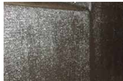
3. Toile de jute recouverte de Wecryl 298 et d'une couche de Wecryl 298 noir.
