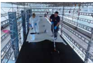
5. Application de la couche de contrôle Wecryl 420 noir sur le toit, après avoir étanché et avoir collé la jute. Cette couche sert à détecter les défauts dans la couche de jute.
