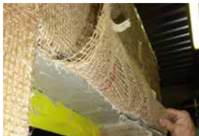
2. Collage de la toile de jute avec du Wecryl 298 sur une couche d'étanchéité Wecryl 230 thix (essai sur l'un des premiers modèles).
