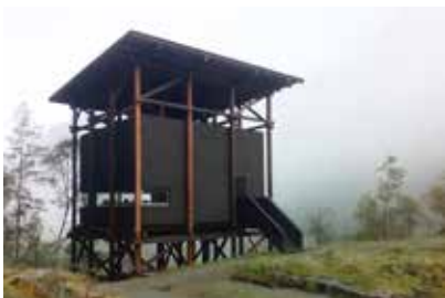
1. Peter Zumthor a trouvé un système d'étanchéité qui résiste aux intempéries violentes, comme ce qui est exigé pour le bois/la jute en Norvège.
